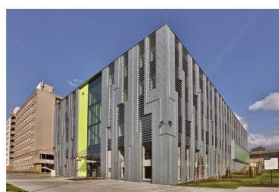
Autor: VŠB Budova ostravského superpočítače.
